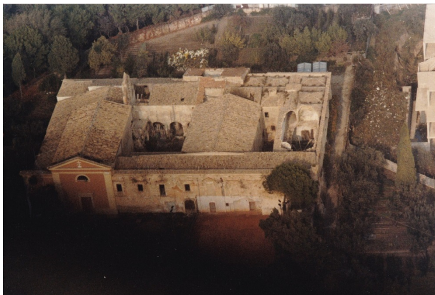
foto 1 - situazione area della fabbrica 1999 - ante recupero
