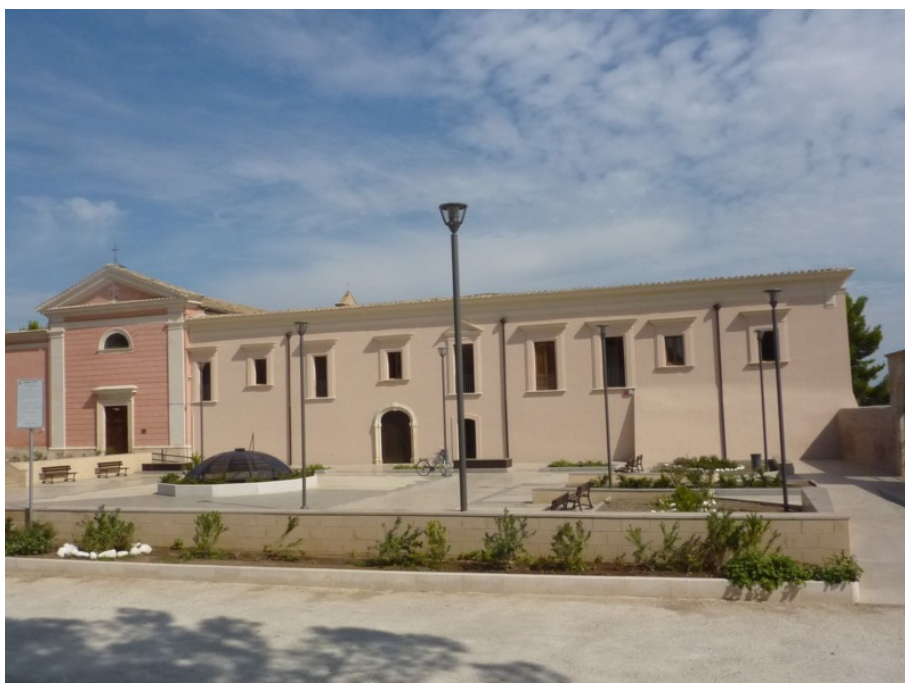
foto 4 - prospetto anteriore della fabbrica 2015 - post recupero
